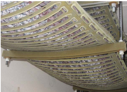
Bild 4: Rinnenmontage auf Schienen
