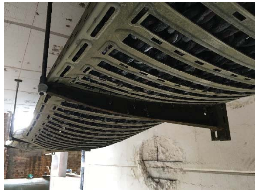
Bild 5: Rinnenmontage auf Ausleger Typ AW 15 41 und Anschlussbauteil AB AW 15
