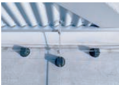
Tilkobling av metallfasader til lynbeskyttelsessystemet
